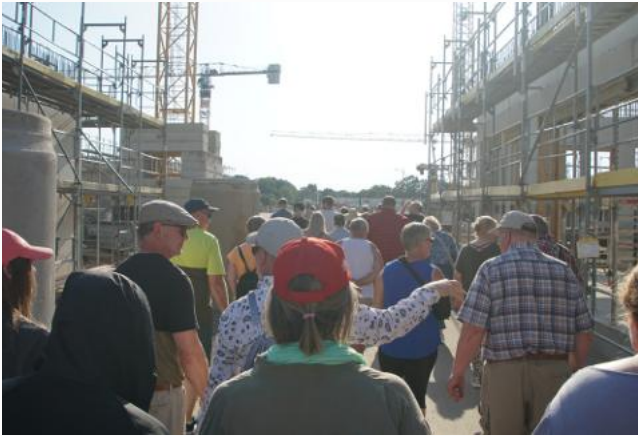
Nachbar*innen aus dem Stadtfeld unternehmen einen ersten Erkundungsgang am künftigen Gefahrenabwehrzentrum
